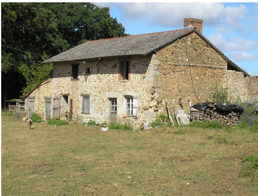
Les bâtiments de ferme occupés par la famille Just en 1944 (photo MB 29/08/2009)
