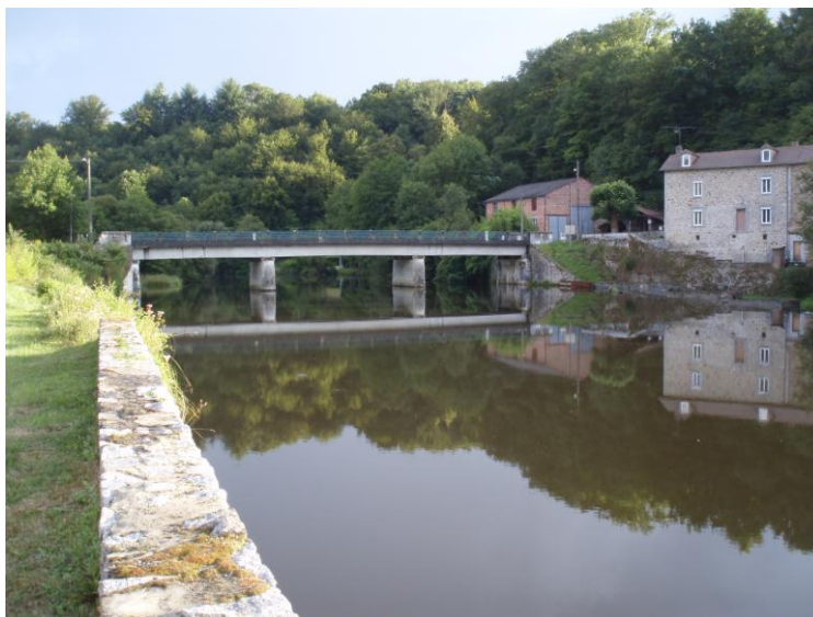
Le pont de Brignac reconstruit (photo MB 15/08/2011)
